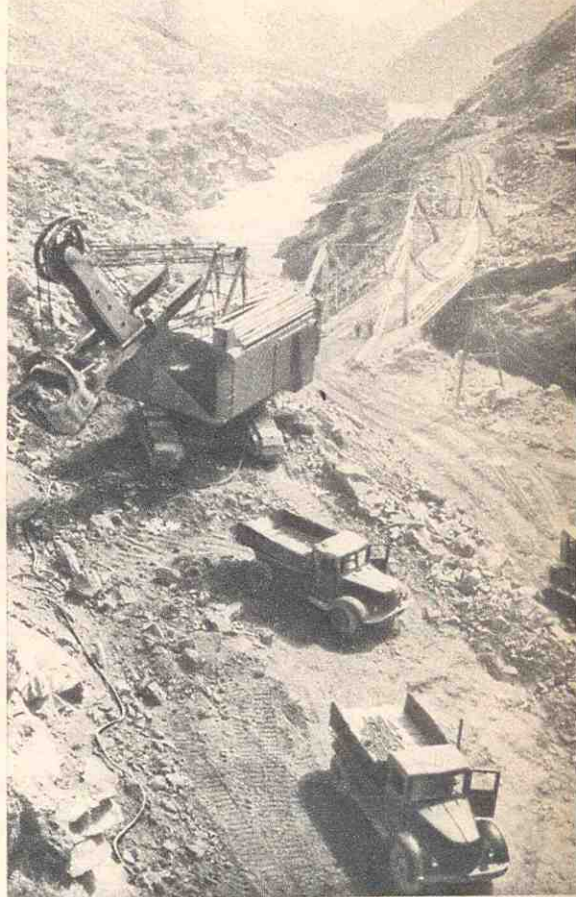
В ущелье Вахша скальный экскаватор пробивает дорогу к месту отсыпки первой очереди плотины НурГЭС.
